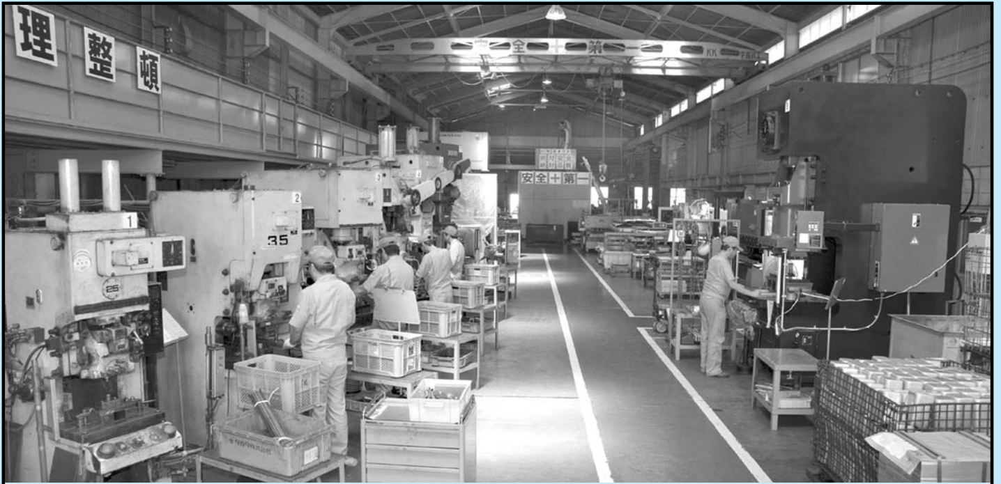
▲第1プレス工場全景
